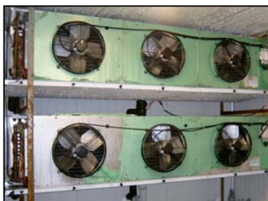
รูปที่ 2-8.6 เครื่องระเหยสารทำความเย็น
