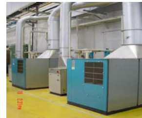
รูปที่ 2-3.22 การติดตั้งเครื่องอัดอากาศที่มีการทำความร้อนทิ้งออกห้อง
