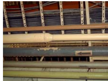
รูปที่ 2-3.23 การเปลี่ยนทิศทางการไหล และการลดขนาดท่อเมนที่ทำให้เกิดการสูญเสียแรงดัน
