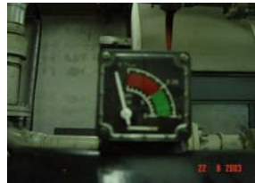
รูปที่ 2-3.48 เครื่องอัดอากาศขาดการบำรุงรักษาที่ชุดกรองอากาศก่อนเข้าเครื่อง
