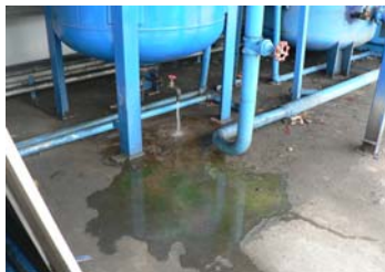
รูปที่ 2-3.49 ถังเก็บอากาศที่มีน้ำขัง กรองอากาศอุดตัน จุดเดรนระบายน้ำทั้งชำรุด
