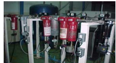
รูปที่ 2-3.48 เครื่องอัดอากาศขาดการบำรุงรักษาที่ชุดกรองอากาศก่อนเข้าเครื่อง
