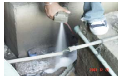
รูปที่ 2-3.49 ถังเก็บอากาศที่มีน้ำขัง กรองอากาศอุดตัน จุดเดรนระบายน้ำทั้งชำรุด
