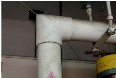
รูปที่ 2-3.23 การเปลี่ยนทิศทางการไหล และการลดขนาดท่อเมนที่ทำให้เกิดการสูญเสียแรงดัน
