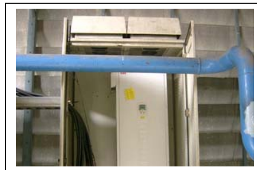
รูปแสดง Air-Compressor หลังปรับปรุง
