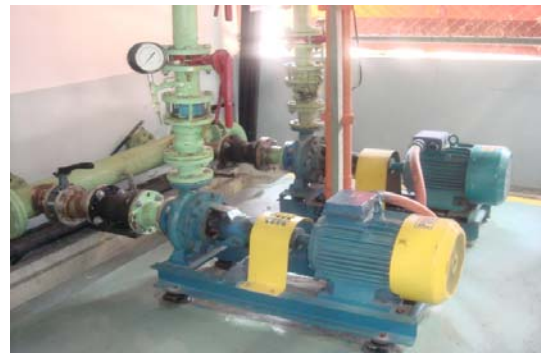
ภาพแสดงปั๊ม ขนาดพิกัด 11 kW ที่ทำการปรับปรุง
