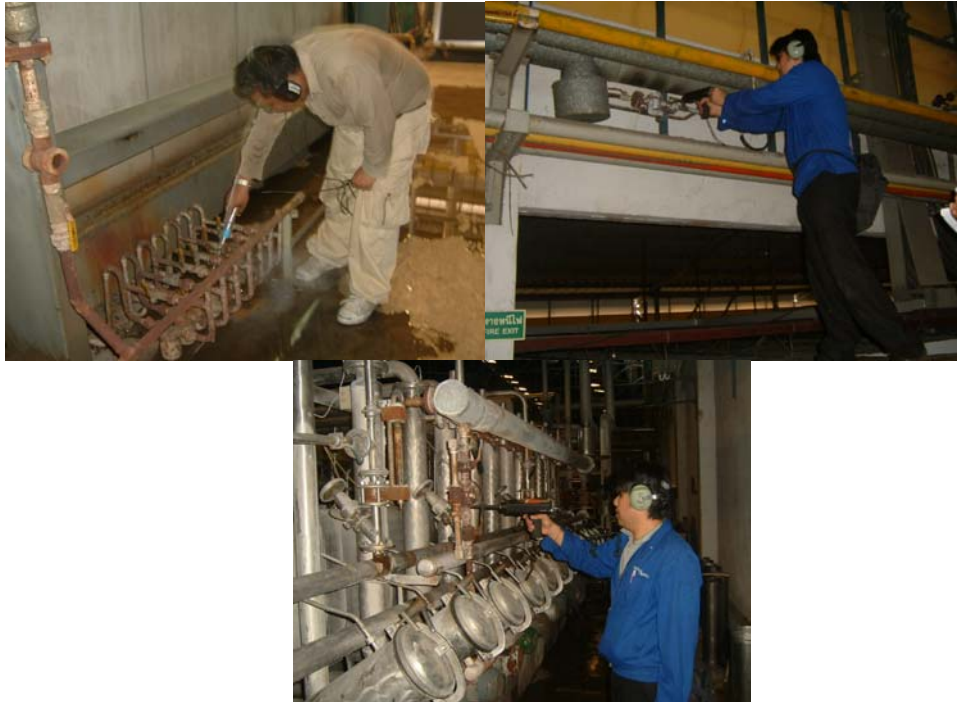
รูปแสดงการตรวจสอบการทำงานของSTEAM TRAP ก่อนทำการปรับปรุง
