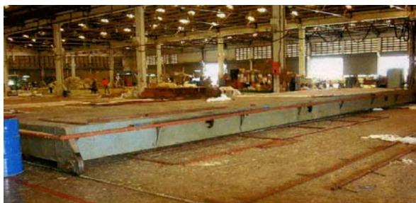
รูปก่อนการปรับปรุง
