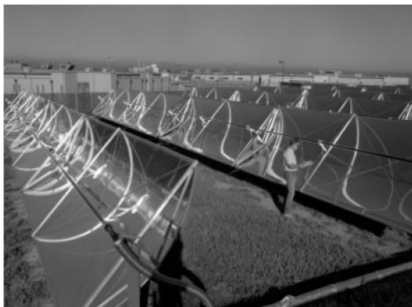
รูปที่ 2-10 แผงรับแสงอาทิตย์แบบพาราโบลิค
