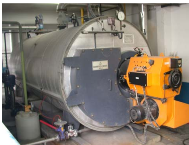
ระบบหลังดำเนินการปรับปรุง โดยเปลี่ยนการใช้เชื้อเพลิงจากน้ำมันเตามาใช้ก๊าซธรรมชาติ
