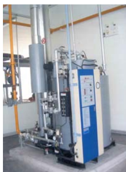
รูปก่อนการปรับปรุง
