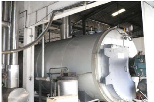
รูปก่อนการปรับปรุง
