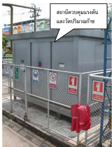
ระบบหลังดำเนินการปรับปรุง โดยเปลี่ยนการใช้เชื้อเพลิงจากน้ำมันเตามาใช้ก๊าซธรรมชาติ
